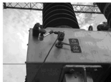
35KV SF6 开关传感器安装 联轴件
